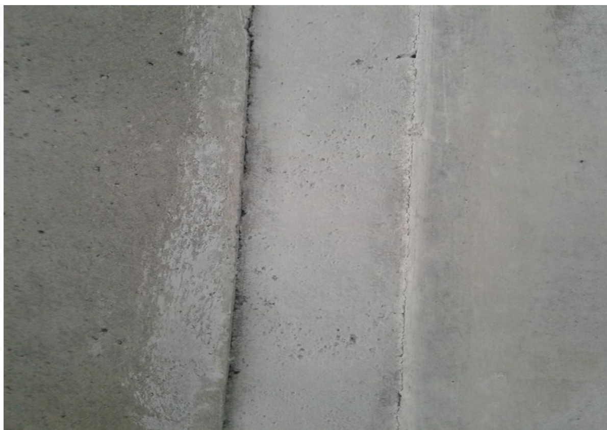
Ściana ze ścianą (połączenie pionowe)
